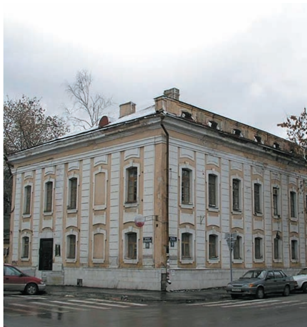
Малое здание Адмиралтейской конторы. Казань. XVIII в. Фото Б.И.Измайлова.
